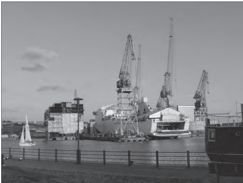
Helsinki, stocznia Hietalahti
